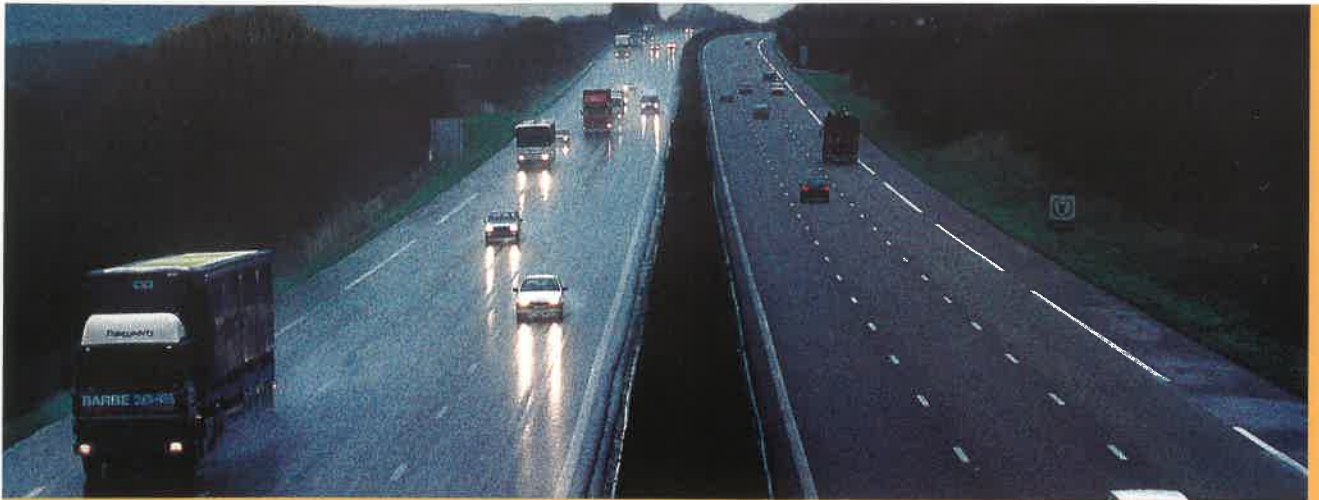
Confronto in un'autostrada francese, tra una pavimentazione drenante, a destra, e una tradizionale, a sinistra
